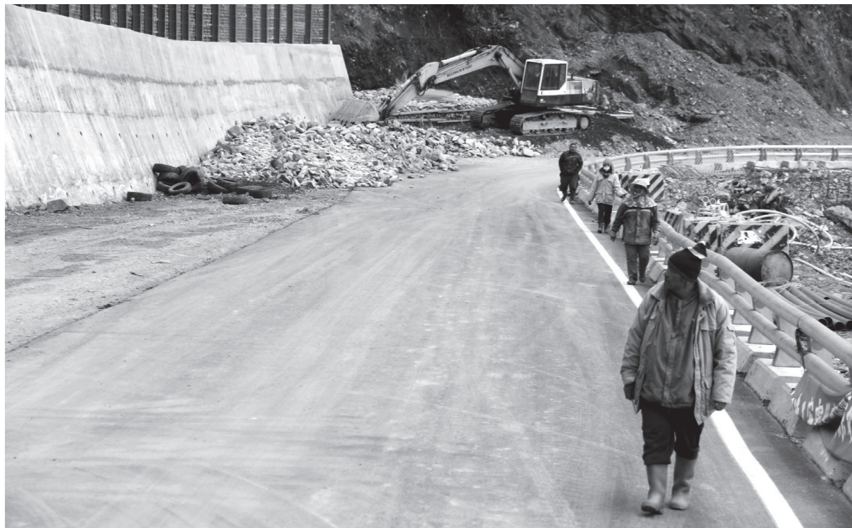
圖二：於南橫公路向陽路段進行公路補強工程（謝博剛拍攝）
