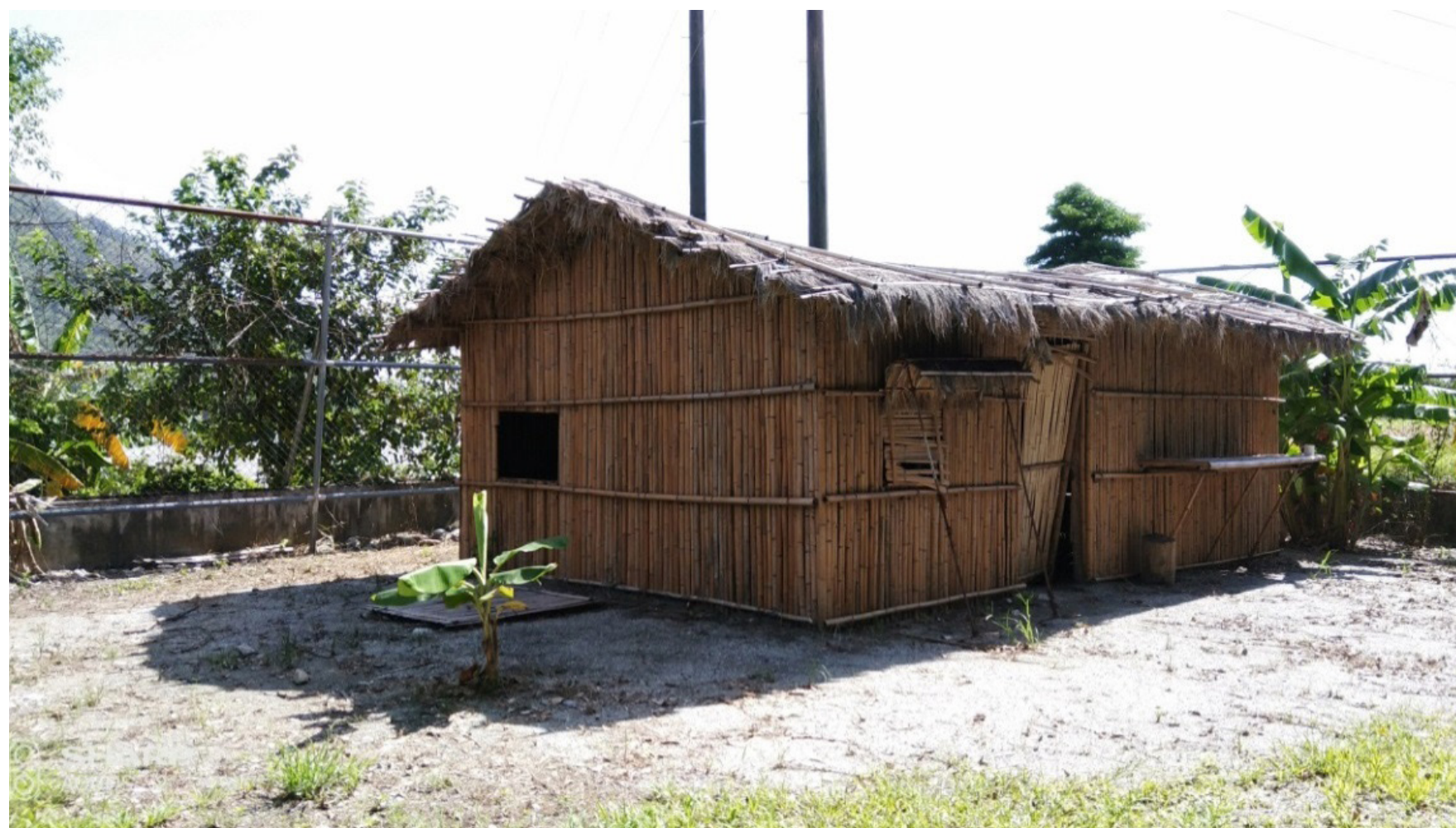
昔日建於校內的茅草屋頂傳統家屋（筆者攝於 2017 年 10 月，原地改建前）
