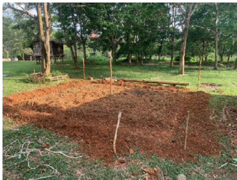
挖地基前先用「小牛」整地。
